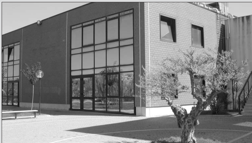
▲ Edificio aule, largo San L. Murialdo 1
